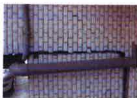
外牆柱斷裂
